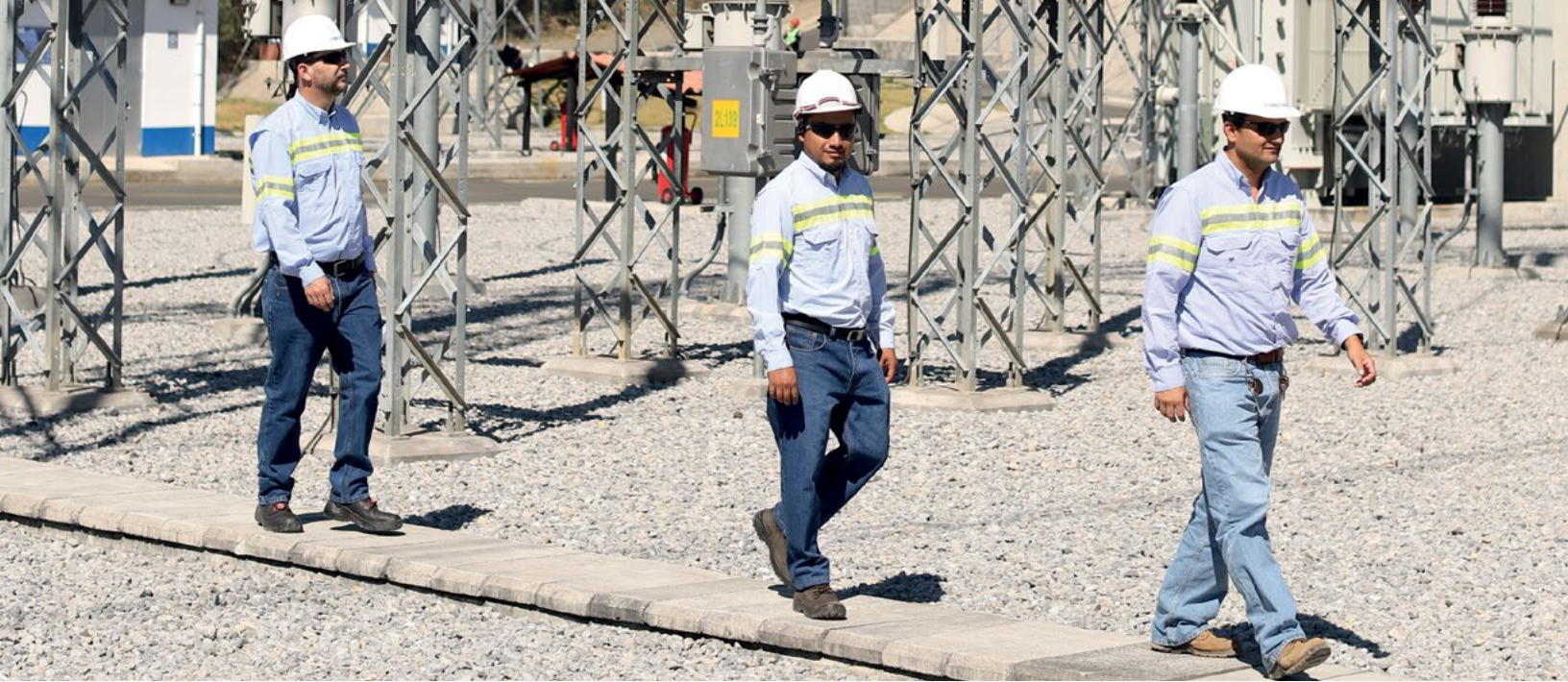
Obras en Anillo Pacífico Sur, Escuintla
