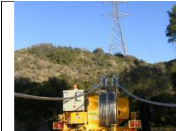
Foto 2.7. Equipos utilizados para el tendido e izado de conductores Fuente: http://omac-italy.it/hp1es.htm http://www.tesmec.com/es/productos/equipos-de-tendido/tendido-aereo/frenadoras.html
