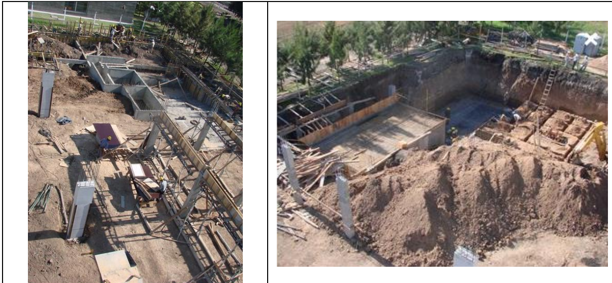
Foto 2.1. Procedimiento constructivo de la malla Fuente: Ecoforest S.A.S., 2015
