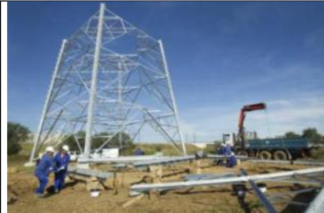
Foto 2.3. Armado de torres Fuente: http://metalworldgroup.com
