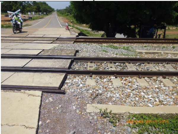
Aspecto de la línea del ferrocarril a Santa Marta, utilizado por las compañías carboneras de la zona para transportar carbón hacia el Puerto de Santa Marta
