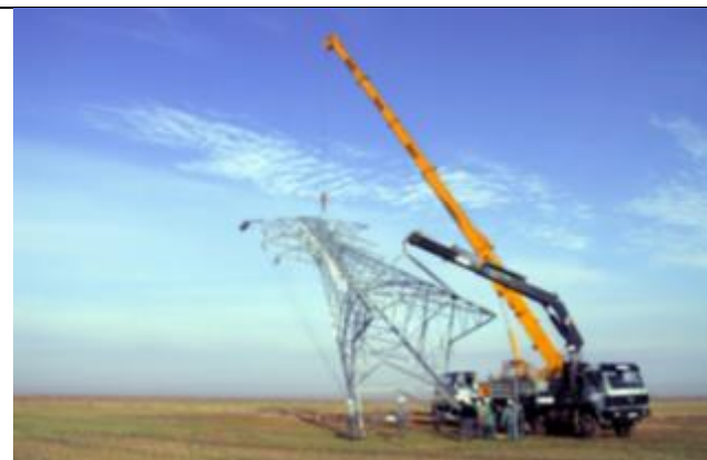
Foto 2.6. Izado de torres con el uso de grúas Fuente: http://metalworldgroup.com
