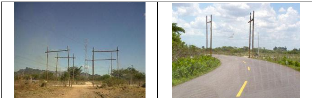
Foto 2.9. Portales para el paso de vías existentes
