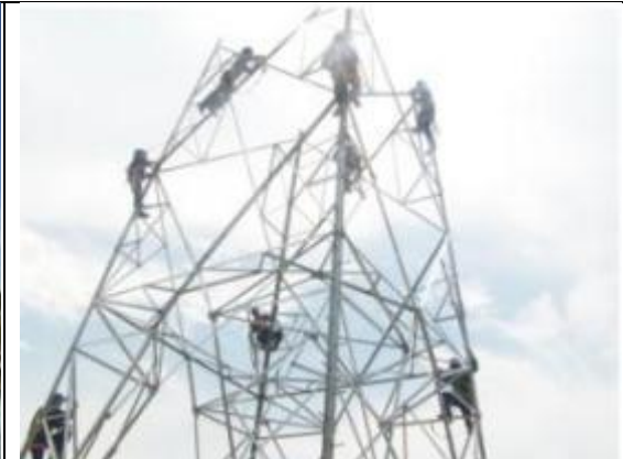
Foto 2.4. Izado de torres con el uso de plumas Fuente: http://metalworldgroup.com
