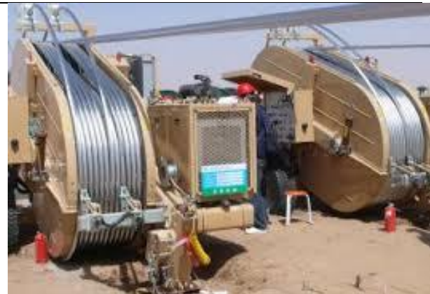
Foto 2.8. Detalle de equipos para tendido e izado de conductores Fuente: http://omac-italy.it/hp1es.htm http://www.tesmec.com/es/productos/equipos-de-tendido/tendido-aereo/frenadoras.html
