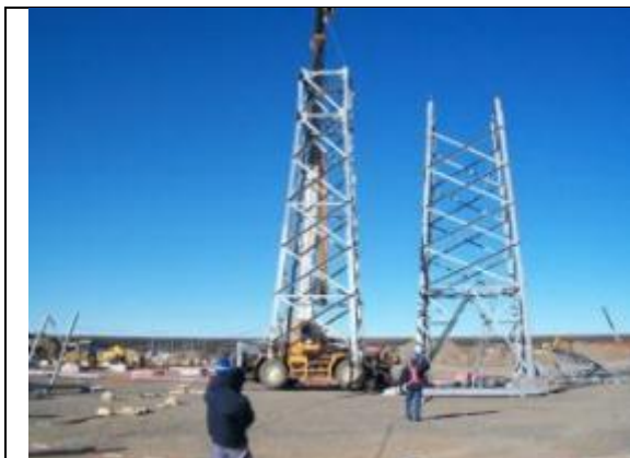
Foto 2.5. Armado de torres con el uso de grúas Fuente: http://metalworldgroup.com
