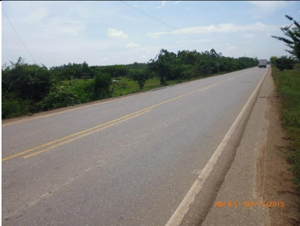
Aspecto general de la Ruta del Sol sector 3, la cual se encuentra en el costado nororiental del área de influencia del proyecto
