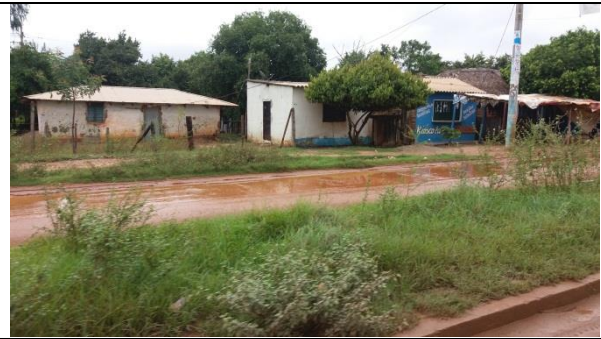
Foto 3.128. Viviendas construidas en bahareque y teje de zinc Fuente: Ecoforest S.A.S., 2015.
