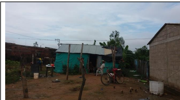
Foto 3.125. Vivienda en bloque y polisombra ofrece regulares condiciones de habitabilidad cuenta con un patio para ampliación y se identifica conexión a servicio de energía y acueducto.
