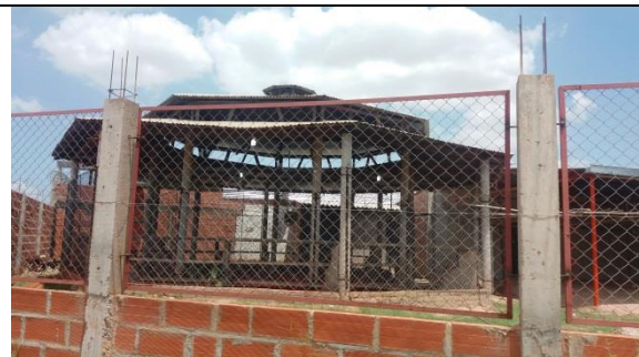
Foto 3.143. Instalaciones de la Gallera Fuente: Ecoforest S.A.S., 2015.
