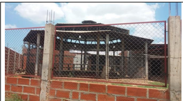
Foto 3.139. Instalaciones de la Gallera Fuente: Ecoforest S.A.S., 2015.
