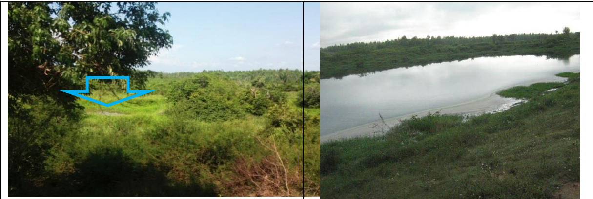
Foto 3.118. Pozos de oxidación de aguas residuales, ubicadas en límites del Barrio el Cruce Fuente: Ecoforest S.A.S., 2015.
