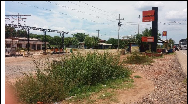
Foto 3.156. Infraestructura de servicios de aprovisionamiento de combustibles y monta llantas, Barrio El Cruce Fuente: Ecoforest S.A.S., 2015.
