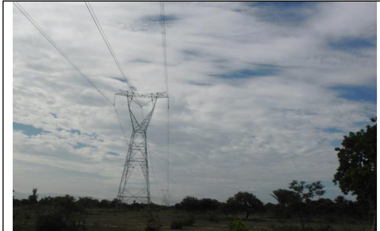
Foto 3.25. Evaluación de la visibilidad con estructuras de redes eléctricas
