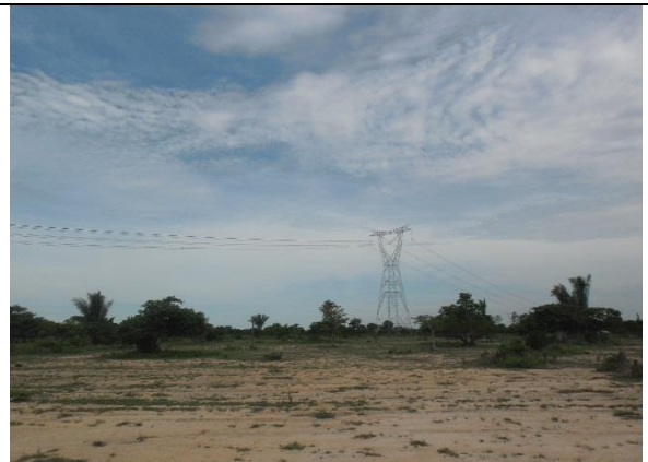
Foto 3.168. Cobertura vegetal de potreros. predios del AID. Fuente: Ecoforest S.A.S., 2015
