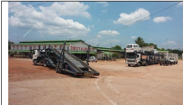
Foto 3.153. Infraestructura de servicios, restaurante y parqueadero ubicado junto a un costado de la Ruta del Sol, Sector 3. Barrio El Cruce Fuente: Ecoforest S.A.S., 2015.
