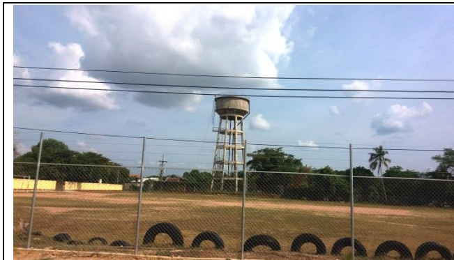
Foto 3.119. Tanque elevado para reserva y distribución de agua en el casco urbano del Corregimiento de La Loma.
