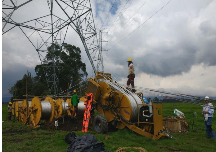
Fotografía 2-7 Detalle de malacate para tendido de cable conductor y de guarda
