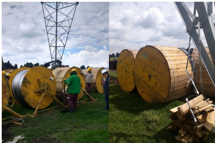
Fotografía 2-5 Detalle de carretes de cable conductor y de guarda Fuente: CONSORCIO INGEDISA DESSAU ANTEA SAN FERNANDO, 2017.
