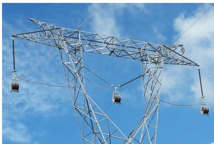
Fotografía 2-5 Detalle de carretes de cable conductor y de guarda Fuente: CONSORCIO INGEDISA DESSAU ANTEA SAN FERNANDO, 2017.
