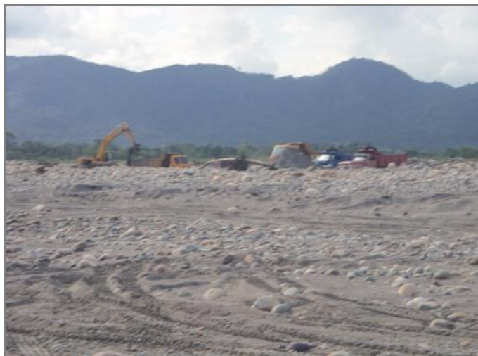
Fotografía 4-19 Extracción de material arrastre Río Guayuriba Fuente: CONSORCIO INGEDISA DESSAU ANTEA SAN FERNANDO, 2017
