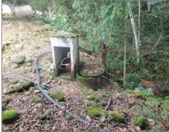
Fotografía 4-15 Captación de agua mediante motobomba
