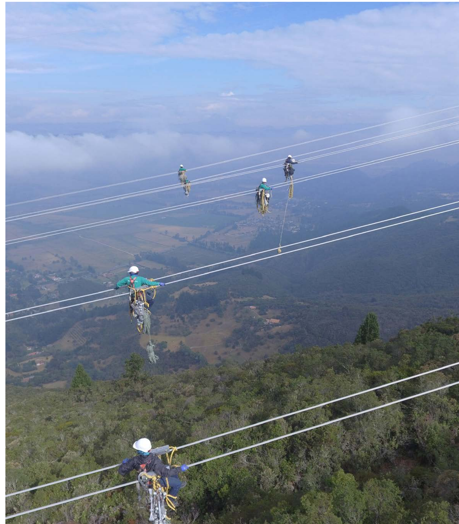
Mantenimiento de líneas de transmisión en Guavio-Circo en Guasca, Cundinamarca
