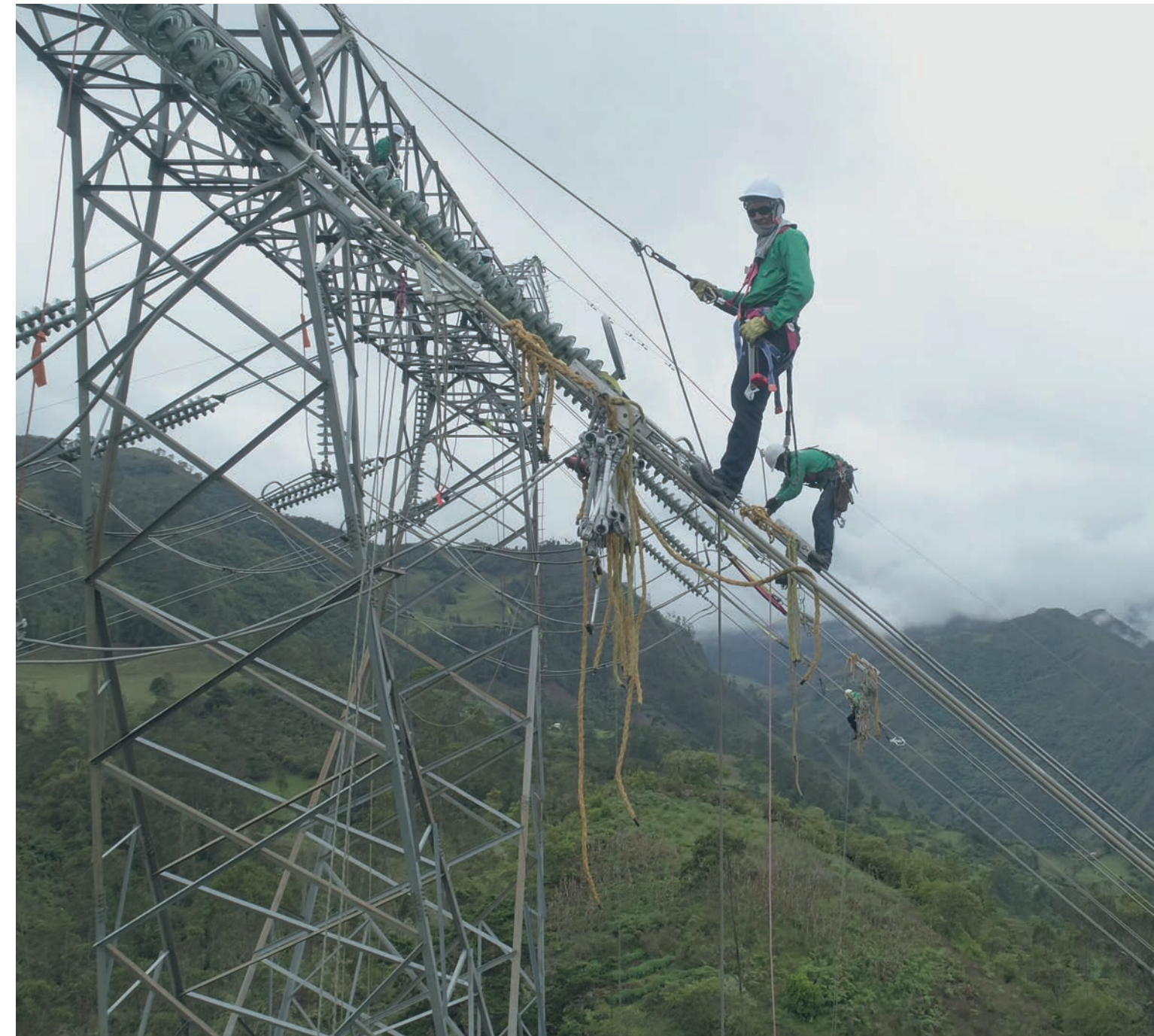
Mantenimiento de líneas de transmisión Circo-Guavio, torre 77
