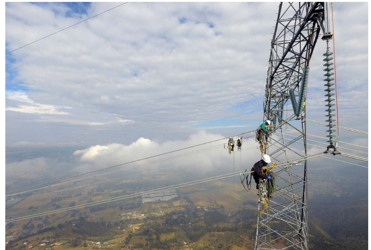
Trabajo de mantenimiento de nuestras líneas de transmisión en Guasca (Cundinamarca)
