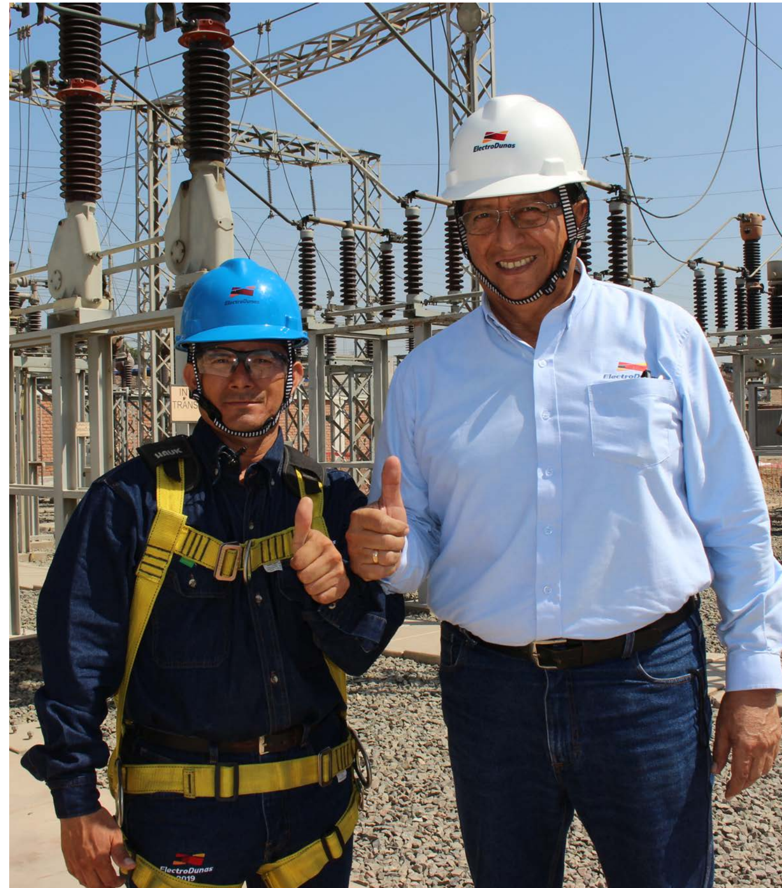
Colaboradores en instalación Ica, Perú
