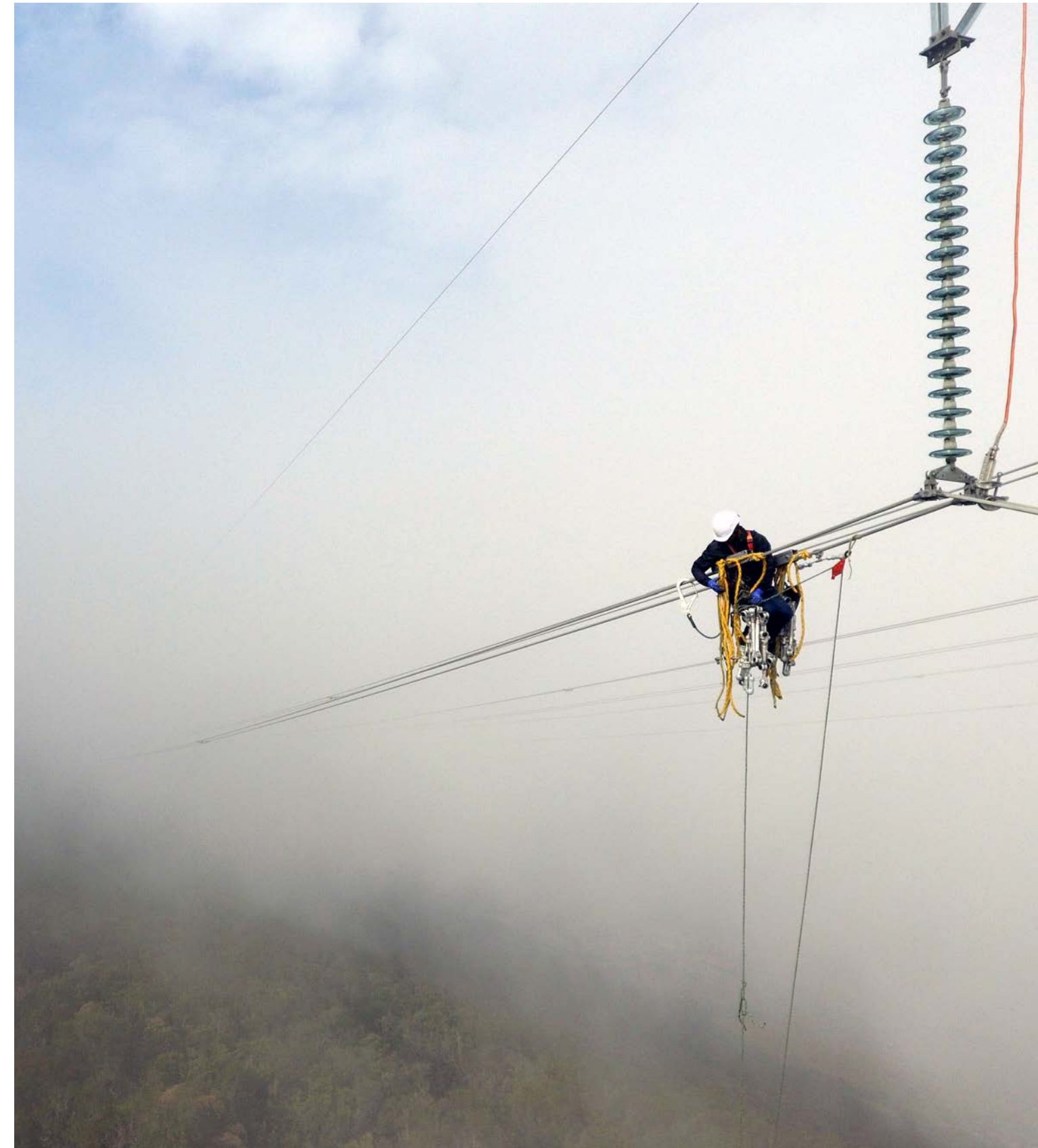
Mantenimiento línea de transmisión en Guasca, Cundinamarca
