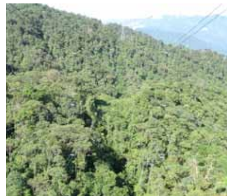
Fotos 113 y 114. Infraestructura de transmisión en la reserva forestal protectora cuenca alta del río Mocoa
