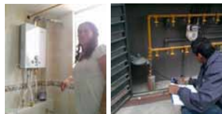
Fotos 58 - 61. Instalación de 3.757 calentadores a gas
