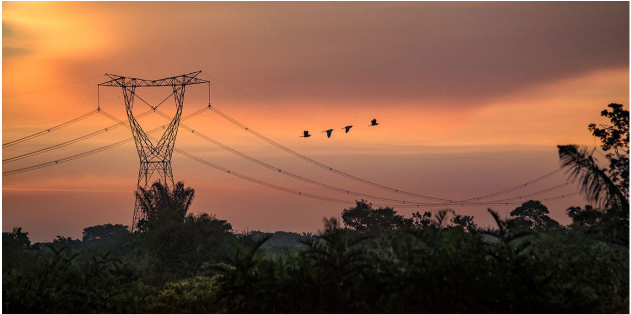
Línea de transmisión de GEB en La Loma, Cesar
