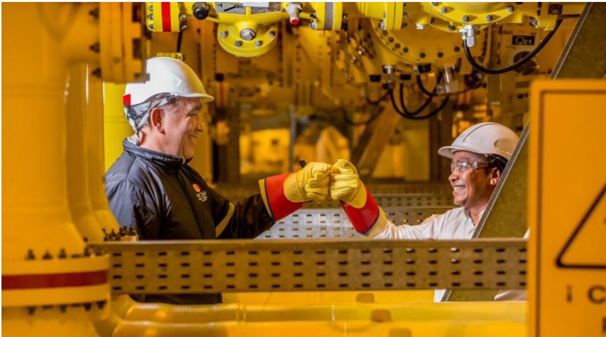
Colaboradores de GEB en casa de máquinas en El Guavio, Cundinamarca
