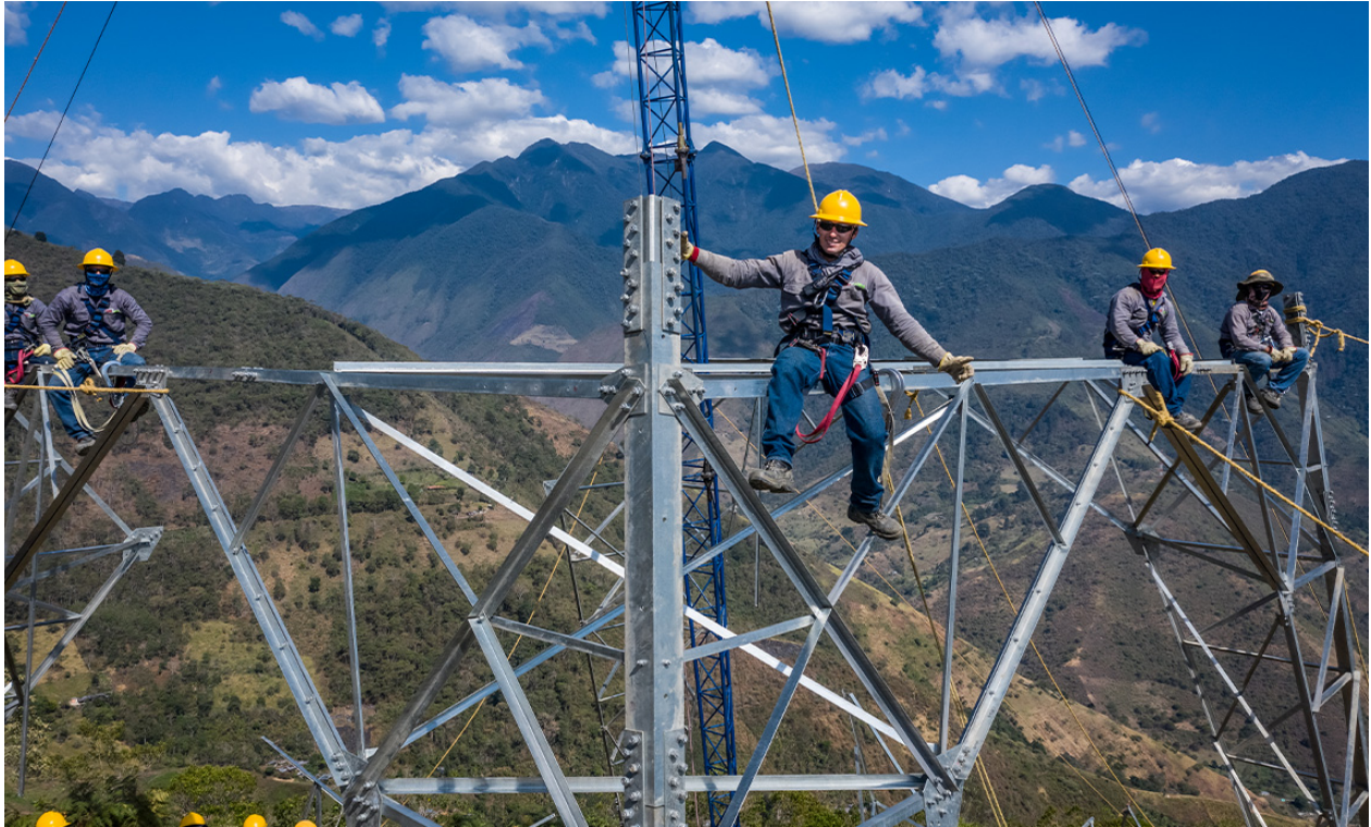
Construcción segundo tramo proyecto Tesalia - Alférez
