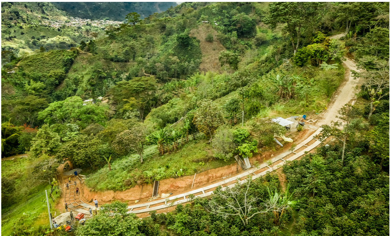
Construimos y mejoramos la infraestructura vial (placa huella) en los territorios donde operamos
