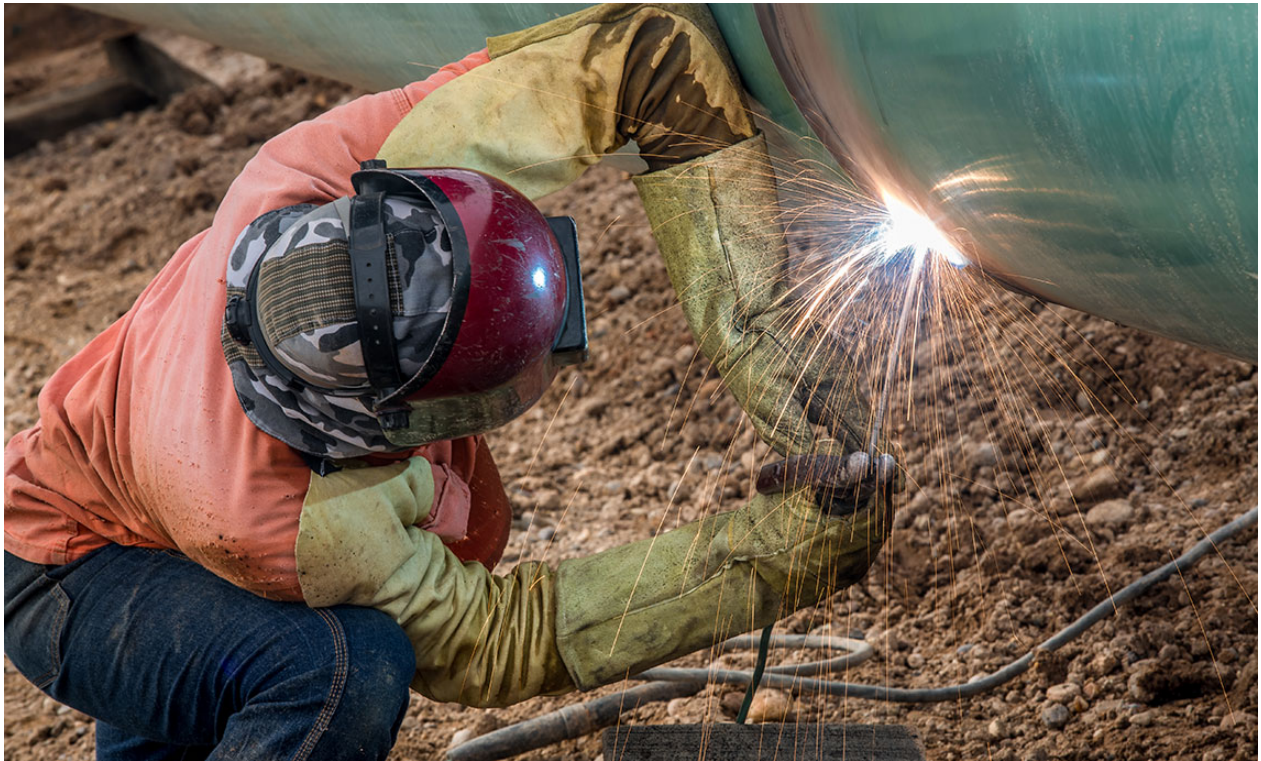
Colaborador de nuestra empresa TGI en labor de mantenimiento
