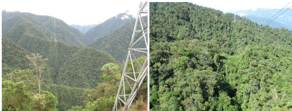
Fotos 113 y 114. Infraestructura de transmisión en la reserva forestal protectora cuenca alta del río Mocoa
