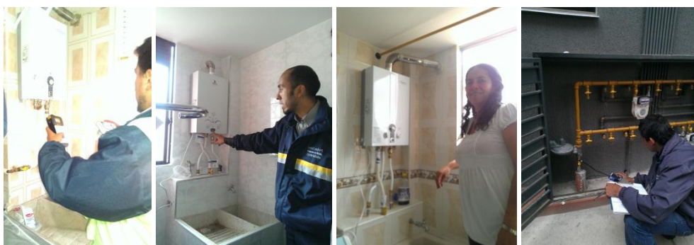
Fotos 58 - 61. Instalación de 3.757 calentadores a gas
